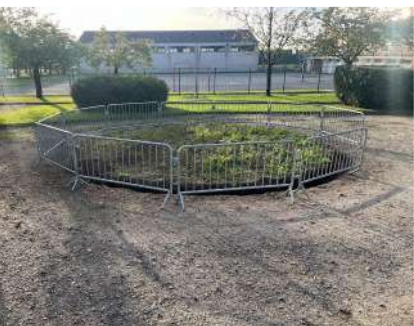
Réalisation d'une aire de « CrossFit » derrière l'Hôtel de Ville
